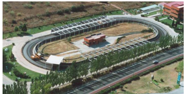
Pista de ensayo acelerado de firmes del CEDEX Autovía de Colmenar Viejo Km 18,2
